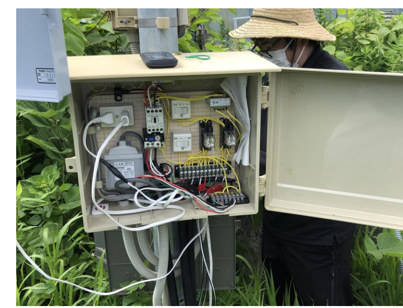
制御BOX(灌水用ポンプ)
