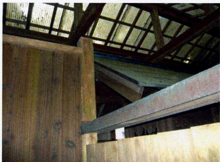
覆屋の中の本殿
